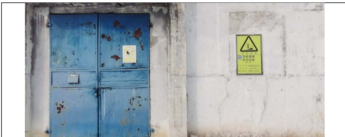
南厂区危废仓库大门
