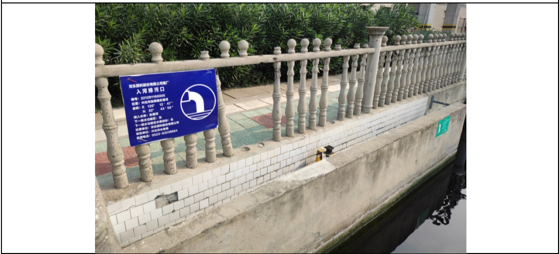
南厂区废水总排口
