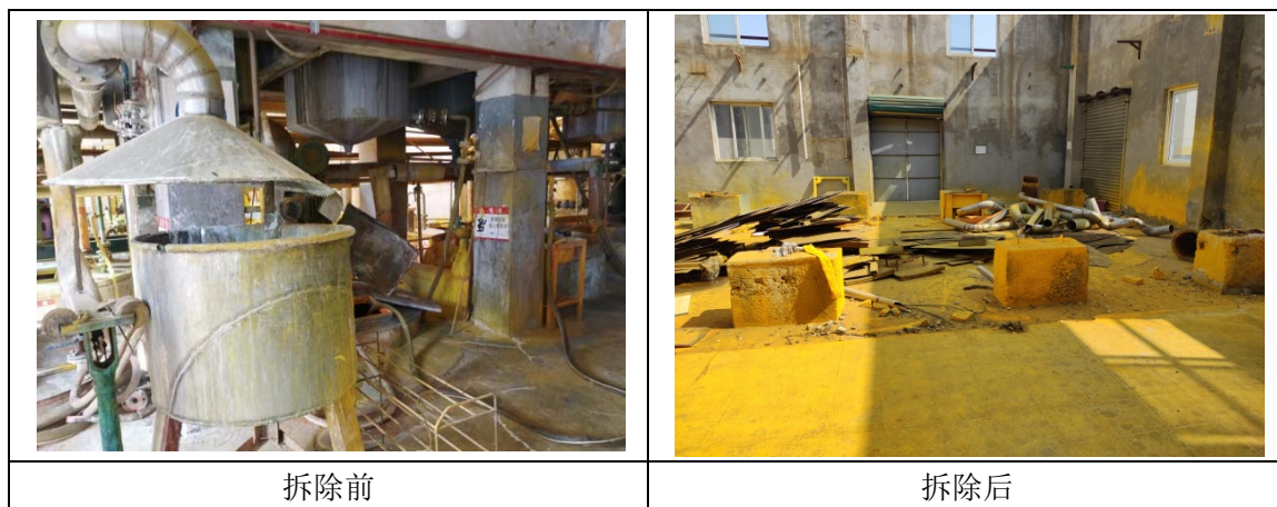
图 3.2-1 原铬三生产线拆除现状照片
